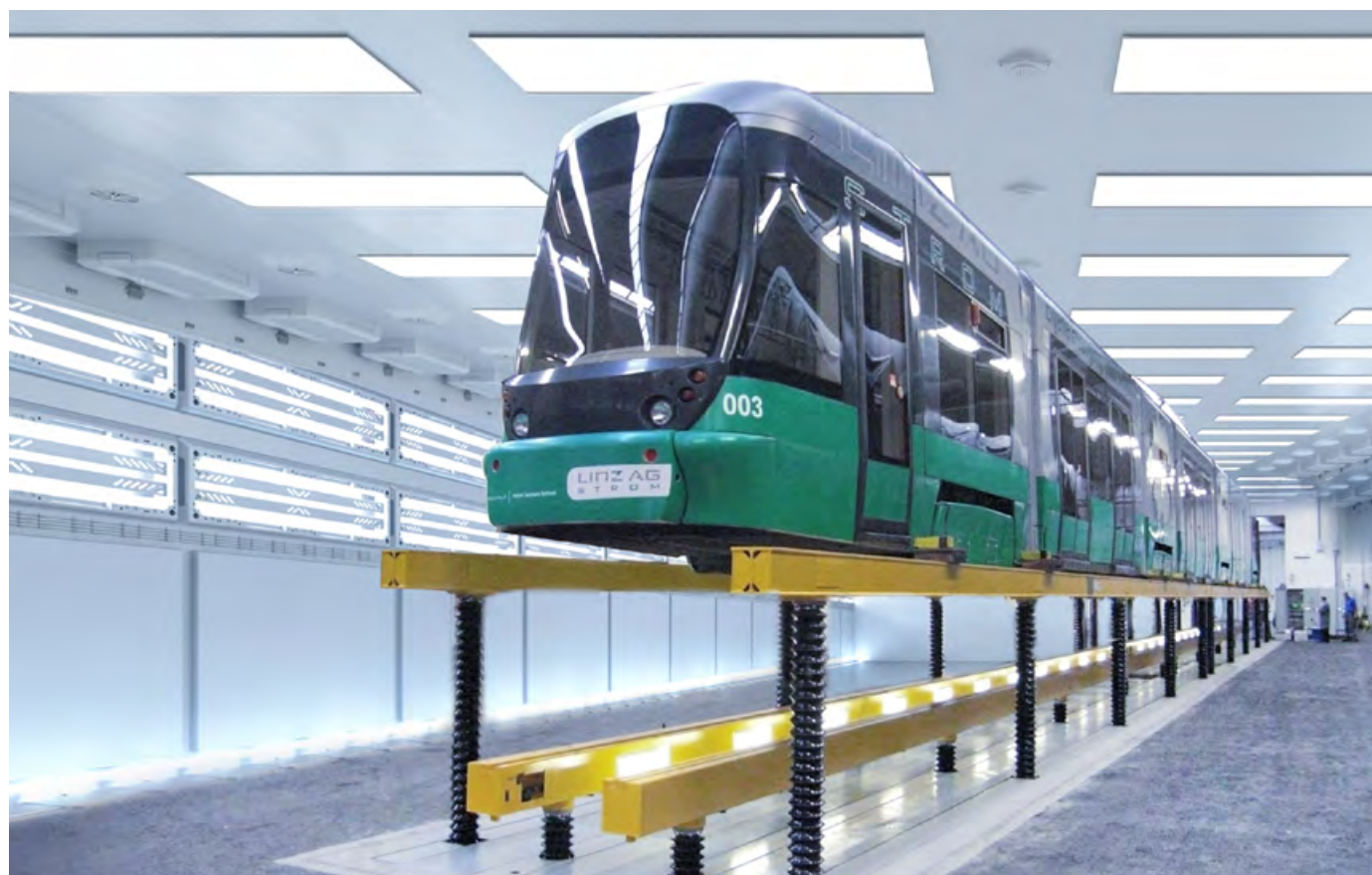
Praff-Unterflurhubanlage mit Spindelhubelementen SHE 25 entsprechend DIN EN 1493 ausgelegt.
